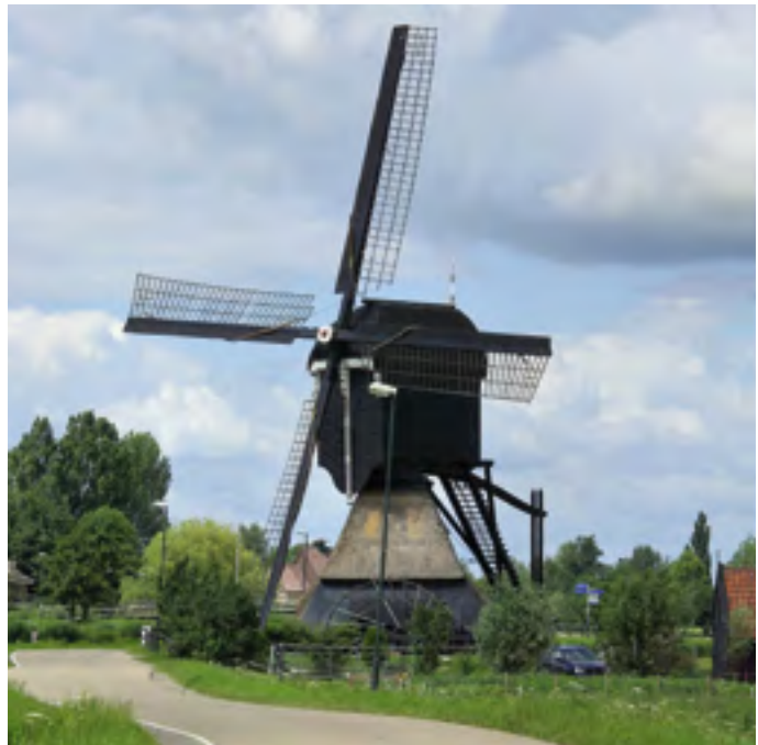
Afb. 1. Met geld uit de Wet BWO werden tientallen poldermolens opgeknapt. Een goed voorbeeld is de Scheijwijkse molen te Hoornaar. In 1954 kreeg de molen een nieuw stormbint. De kosten werden grotendeels gedragen door het Rijk ingevolge de Wet BWO. Dit gold ook voor allerlei in latere jaren uitgevoerde werken aan deze molen. Foto Stichting tot Instandhouding van Molens in de Alblasserwaard en de Vijfheerenlanden.
