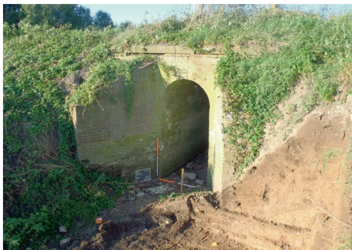
Afb. 4. De oostelijke gevel van de duikersluis onder de Buitenstad zoals hij aanwezig was tot de start van de werkzaamheden in het kader van Ruimte voor de Lek.
