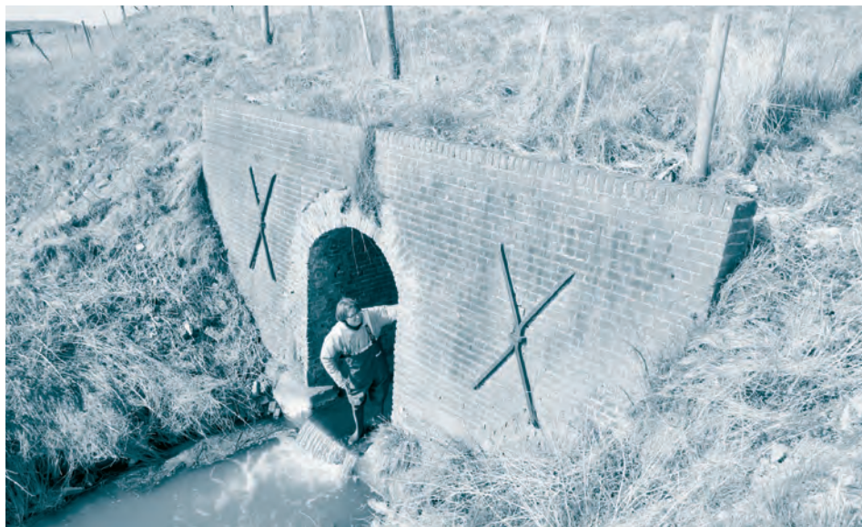
Afb. 2. Inspectie van de voormalige uitwateringssluis van de Westerlandpolder bij Wolphaartsdijk.
