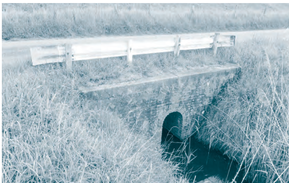
Afb. 3. De uitwateringssluis van de Kanaalpolder in Philippine (object KDU26363).
