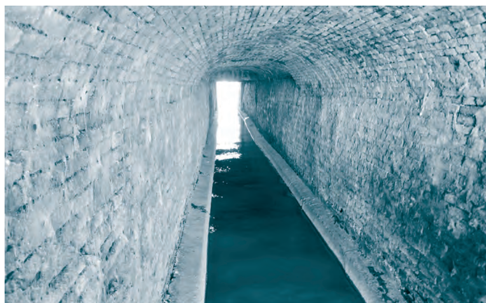
Afb. 7. Koker van de uitwateringssluis van de Westerlandpolder.
