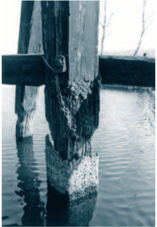
Een oud verdedigingsmiddel tegen paalwormvraat: geheel met spijkers met een grote platte kop – zogenaamde wormspijkers – betimmerde dukdalf. Foto Hoogheemraadschap Hollands Noorderkwartier.
