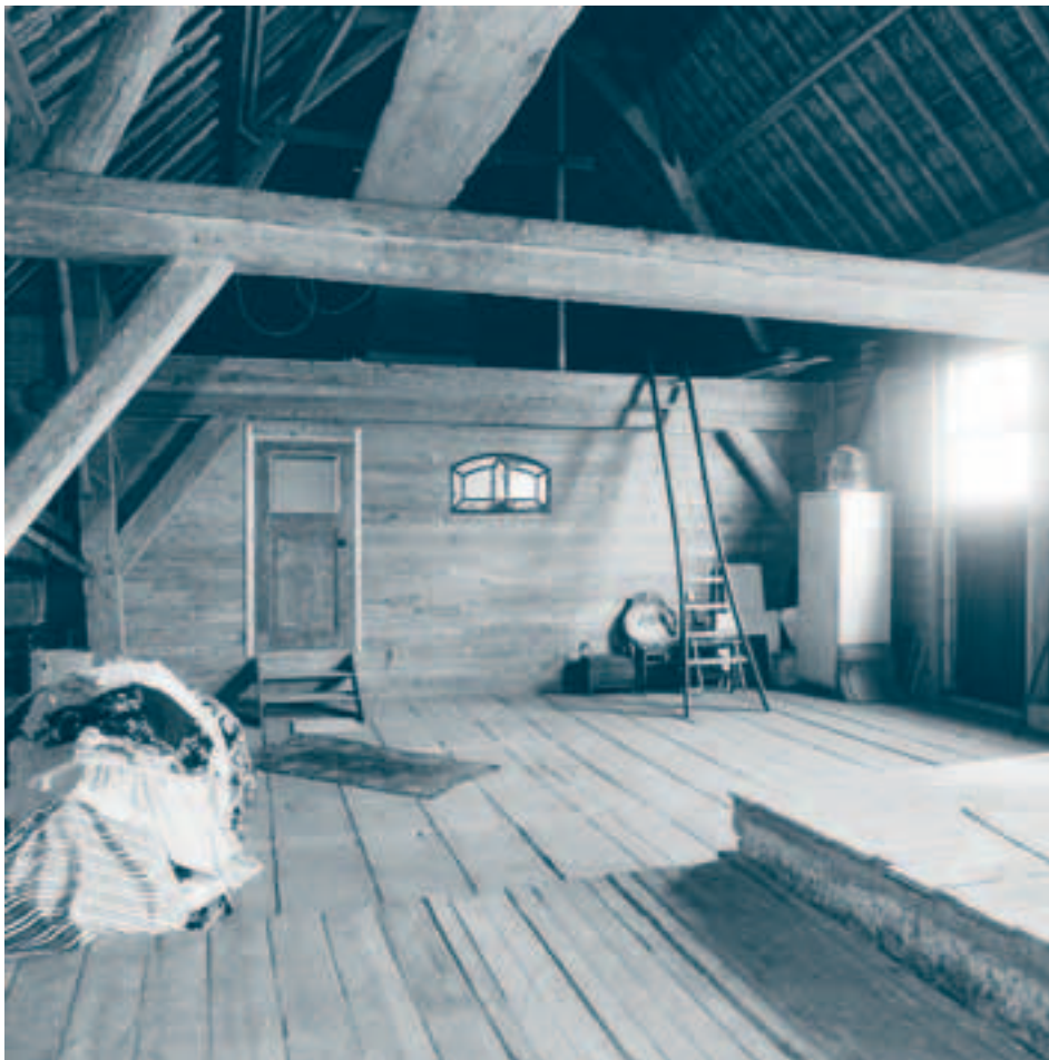
Afb. 6. Smalzijde 12, Nieuwland: op de zolder is een hoogtevverschil waar te nemen, rechts op de foto, dat dienst deed als waterzolder. Dit gedeelte was verzaamd uitgevoerd om het gewicht van het vee te kunnen dragen. Fotoarchief Rijksdienst voor het Cultureel Erfgoed.
