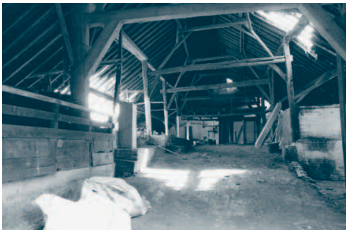
Afb. 5. Burggraaf 6, Meerkerk: in de boerderij is een waterstal op een aarden bult aanwezig. Door het oplopende talud konden de koeien naar de stal. Fotoarchief Rijksdienst voor het Cultureel Erfgoed.
