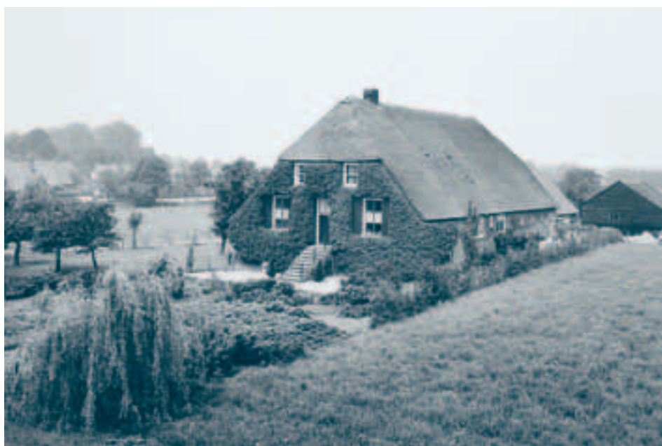
Afb. 8. Waalbanddijk 83, Dodewaard: de boerderij is geheel 'op hoogte' gebouwd. Aan de trap tegen de voor-gevel is zichtbaar hoe hoog de gehele begane grond van het woongedeelte is gelegen. Fotoarchief Rijksdienst voor het Cultureel Erfgoed.
