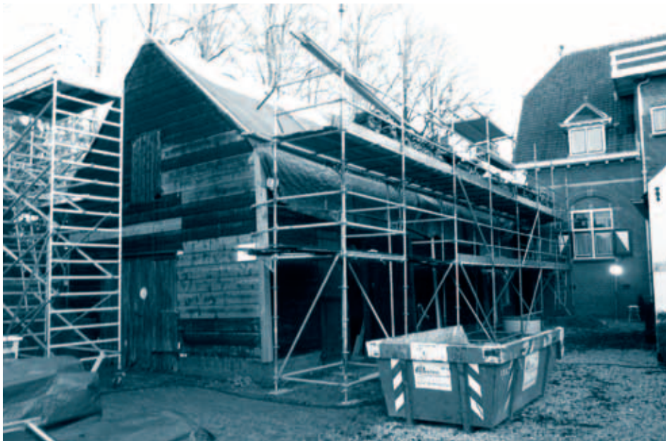
De zwarte schuur bij het Dijkhuis Jaarsveld tijdens de restauratie. Foto Hoogheemraadschap de Stichtse Rijnlanden.
