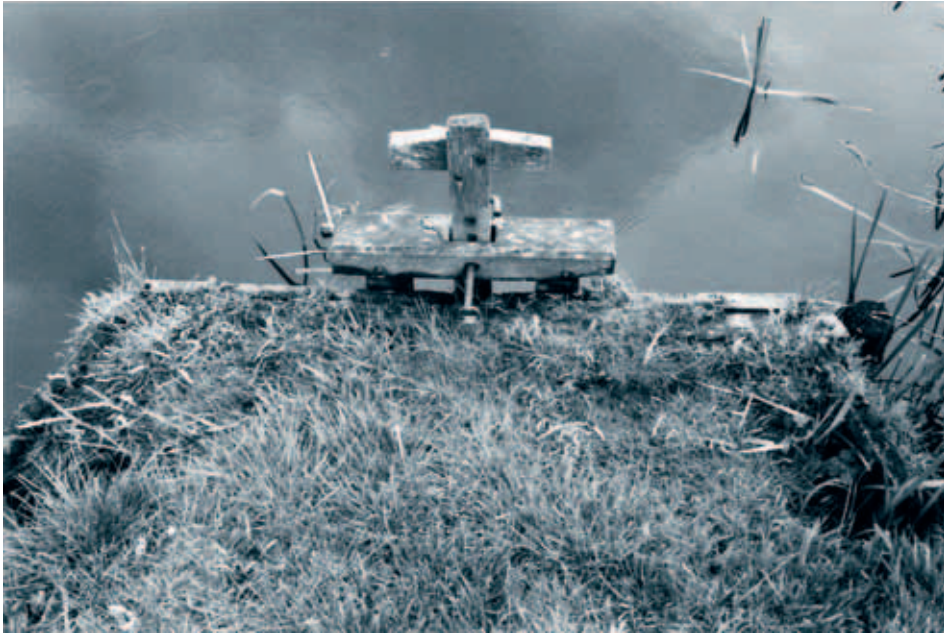
Afb. 2. Een 'pomp' aan de ringdijk van de Bergermeerpolder, dienende als inlaatsluisje. Foto auteur, 2010.
