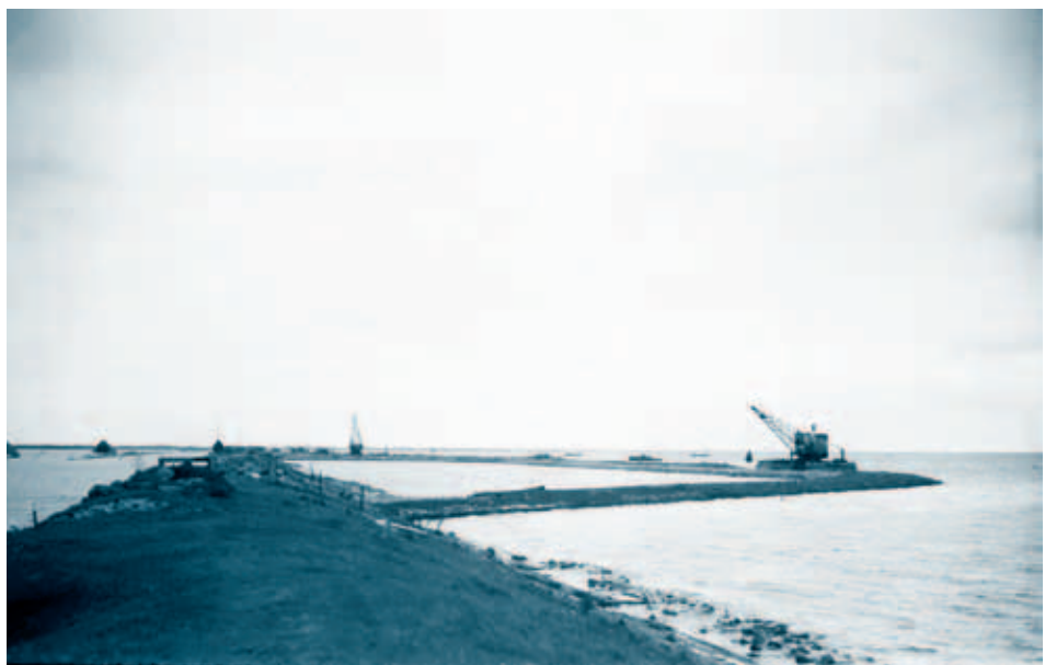
Afb. 8. Herstelwerkzaamheden in augustus 1945. De nieuwe dijk om de bresgaten is gesloten. Er kan begonnen worden met het leegpompen van de polder. Collectie W. Verkerk, Zuiderzeemuseum, Enkhuizen.
