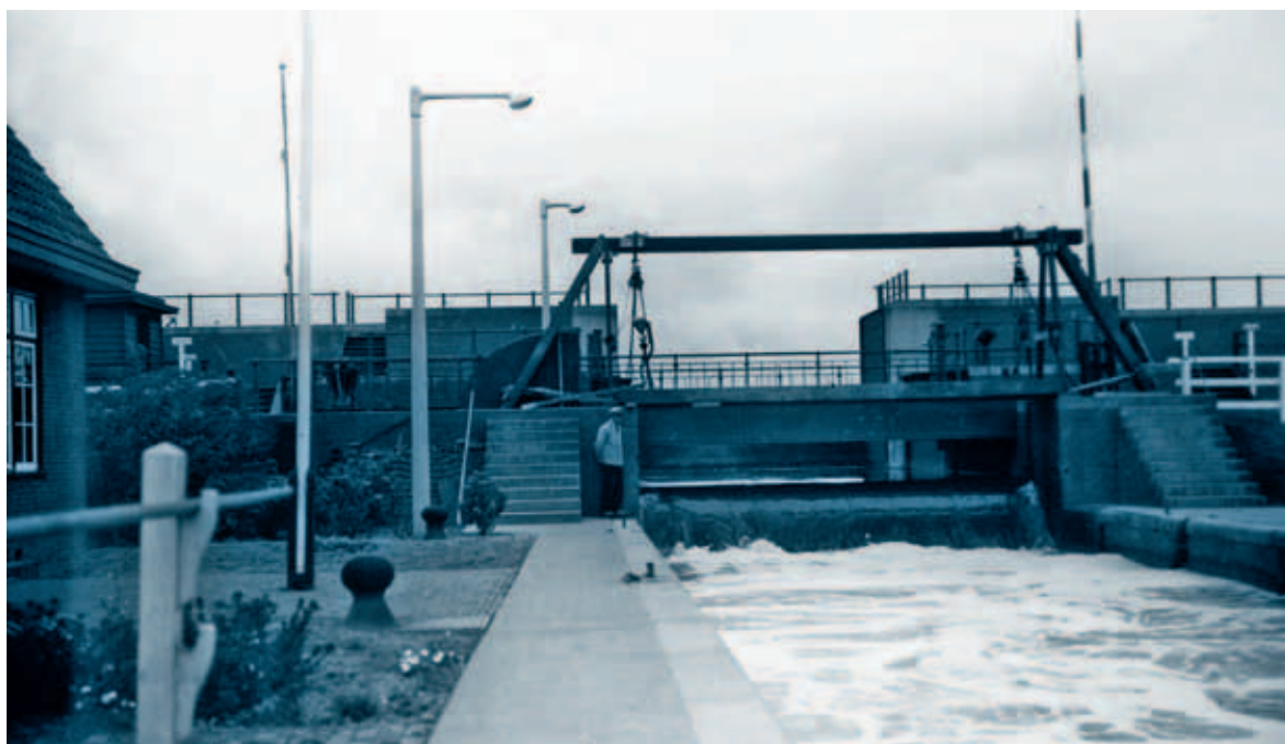
Afb. 10. De Overle- kersluis bij Medemblik waardoor water uit de Wieringermeer naar de Vier Noorder Koggen is afgelaten. Met de tij- delijke hijsconstructie kon door het aanbrengen of wegnemen van schotbalken het debiet worden gereguleerd. Collectie W. Verkerk, Zuiderzeemuseum, Enkhuizen.
