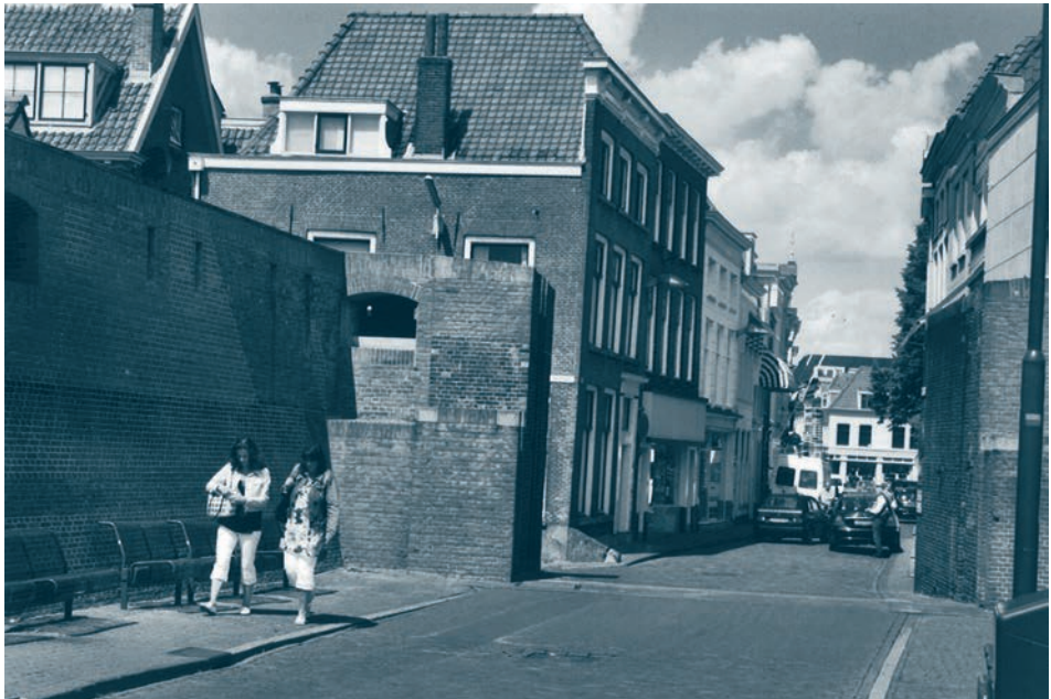
Afb. 6. Coupe in de stenendijk te Gorinchem, met gleuven voor het aanbrengen van hoogwatervoorzieningen. Foto auteur 2009.
