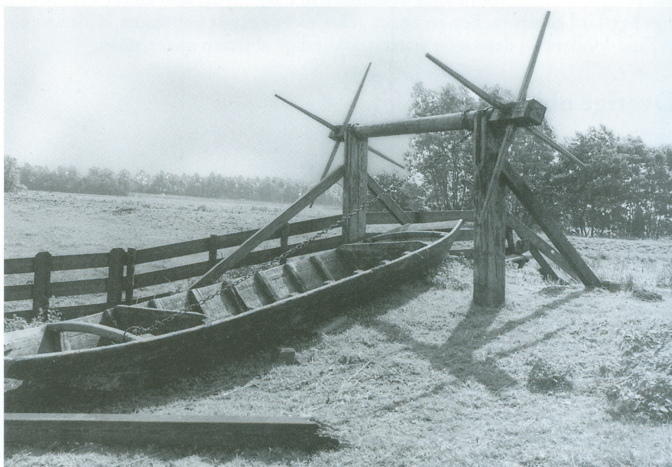
2. De overtoom gezien vanuit het noordwesten. Links van de schuit en direct achter het draagstel met de windas bevinden zich wateren (foto: G.J. Dukker, MSP Z-H, 1996).
