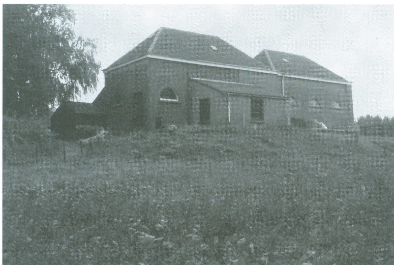
18. Het gemaal van de Polder van Nootdorp vanuit het noorden. Deze opname vanaf de bodem van de polder toont de uiterst sobere achterzijde van het gemaal in ambachtelijk-traditionele trant. Let op de verschillende hoogten van de beide volumes en op de originele, halfcirkelvormige vensters.
