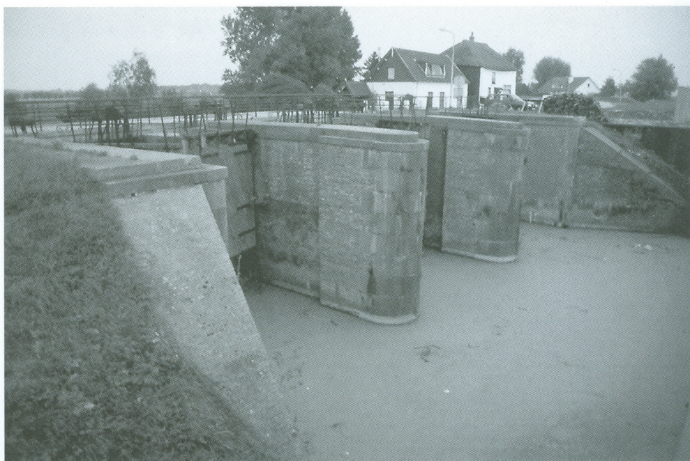
14. De Ambtssluis met de drie parallelle sluiskolken vanuit het zuidwesten. Links op de achtergrond de eventueel te inunderen gronden (foto: A.F.J. Nijmeijer, 1996).
