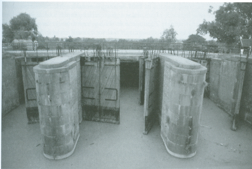
15. De Ambtssluys te Dalem vanuit het zuiden, met in de middelste kolk de drie paren puntdeuren – twee geopend, de derde gesloten (foto: A.F.J. Niemeijer, 1996).
