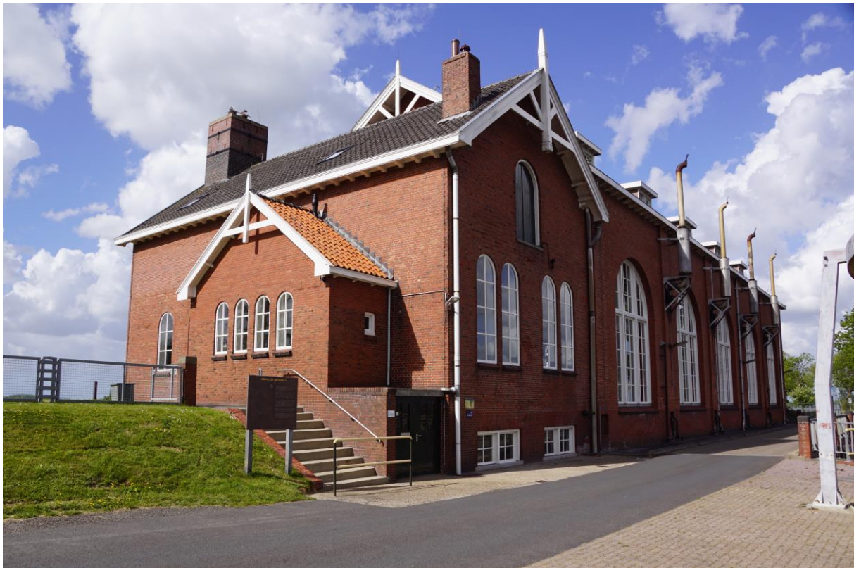
Boezemgemaal „De Waterwolf” in Lauwerzijl
